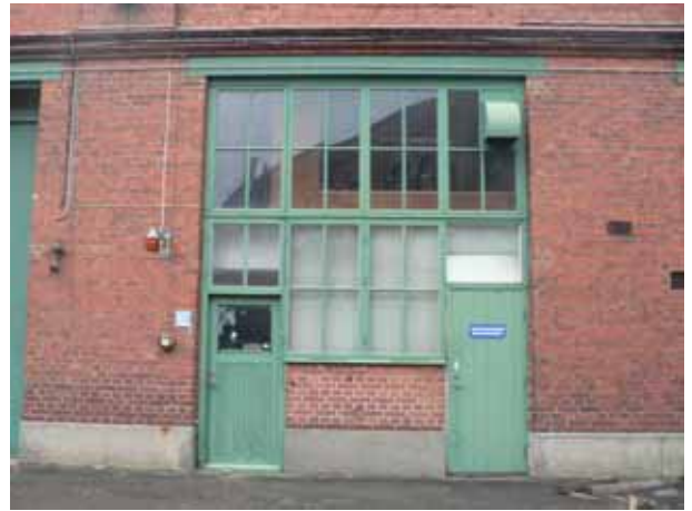
Dörr- och fönsterparti, Vagnsverkstadens södra fasad.
