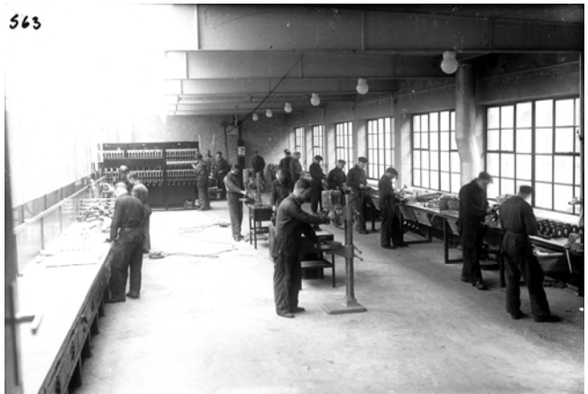
563 Interiörbild från rör- och elektrikerverkstaden, 1940-tal.
