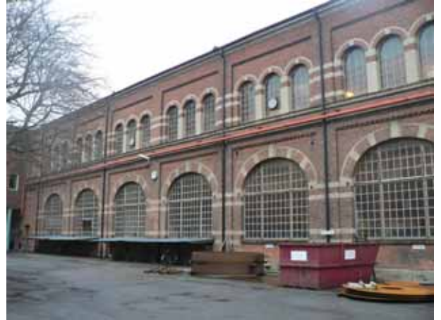
Monteringshallens västra fasad.
