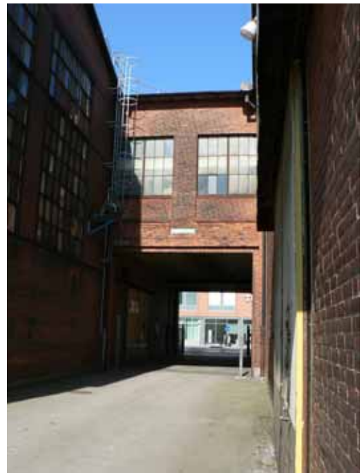
Passagen mellan maskinhall 2A och 2B. Sedd från söder.
