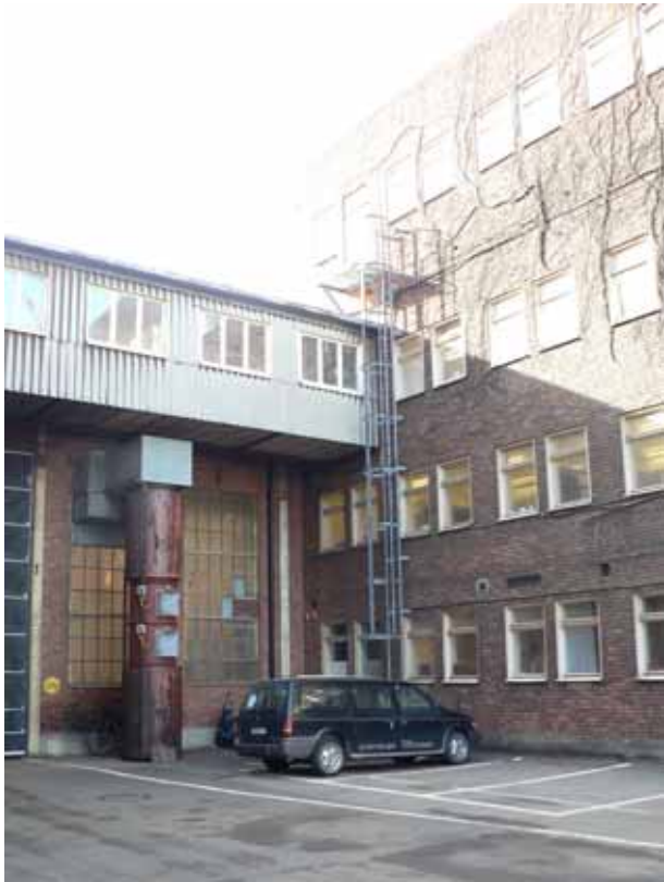
Plåtslageriets norra fasad.
