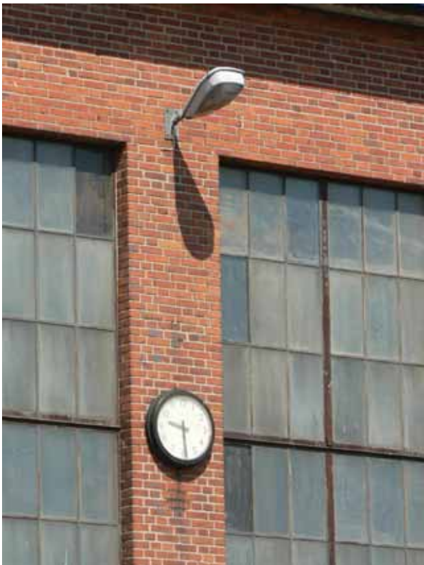
Detalj av maskinhallens södra fasad.
