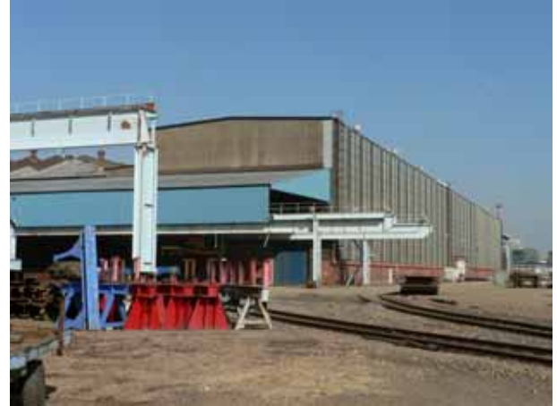
Detalsamlingshallen sedd från väster.
