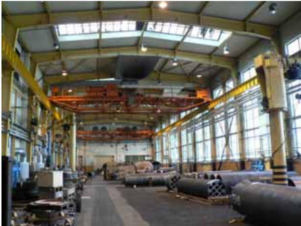
Maskinhallen sedd från öster. I fonden syns väggen mot maskinverkstaden (5A).
