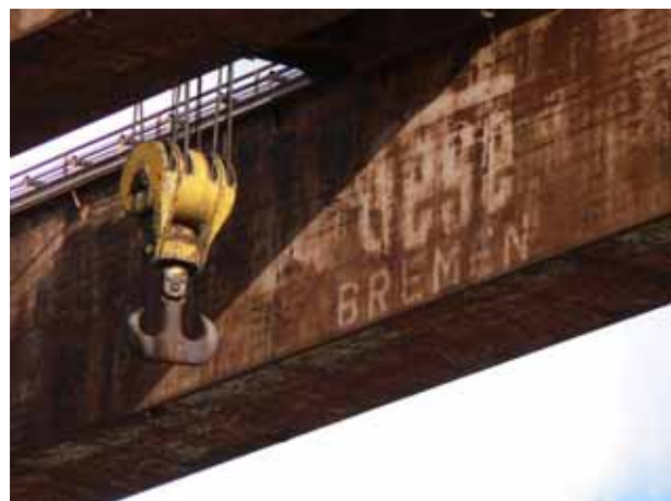
Detalj av travers utanför svetshallarna.
