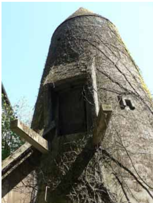
Ingång till skyddsrummet, på dess västra sida.
