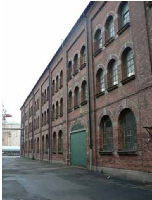
Montagehallens östra fasad.
