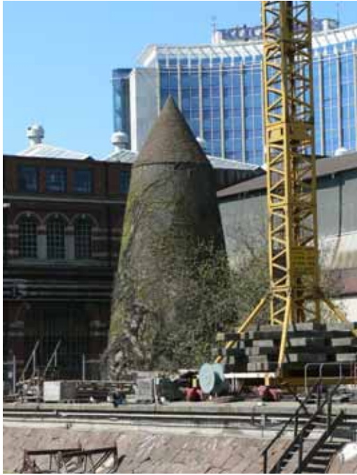
Skyddsrummet sett från sydost.
