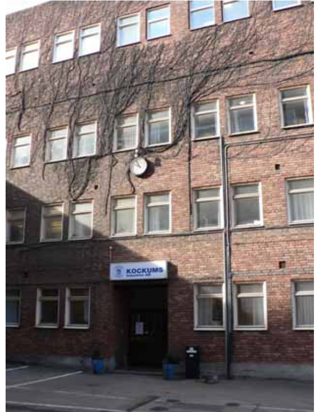
Entrén vid den östra fasaden.
