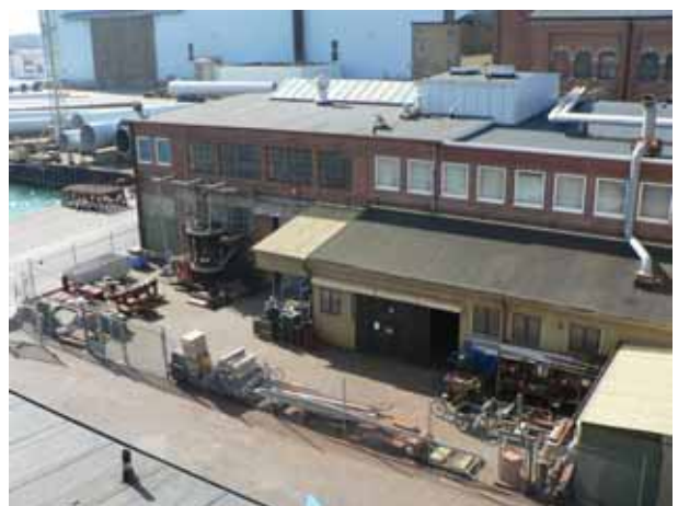
Rör- och elektrikerverkstaden sedd från nordost.
