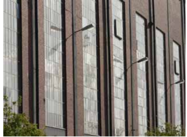
Bevarade småspröjsade järnfönster.
