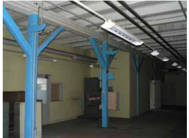
Interiört. Träpelare, bottenvåningen.
