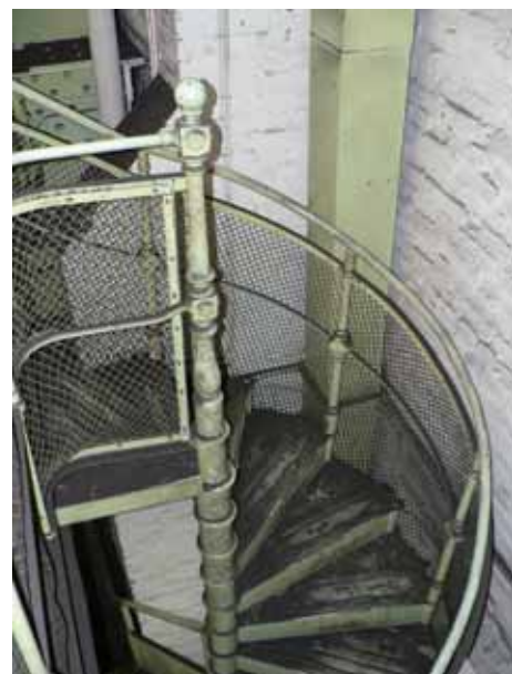
Spiraltrappa i verkstadens norra del.
