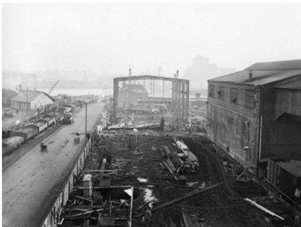
Maskinhall 2A och 2B håller på att uppföras, 1945. Vy från väster, Stora Varvsgatan till vänster i bild.
