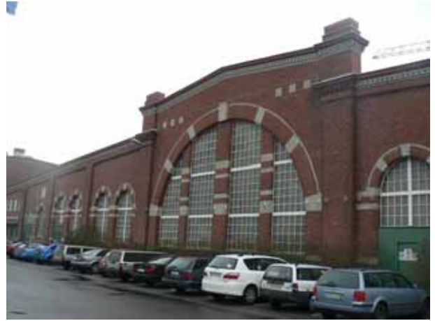
Vagnsverkstadens norra fasad.
