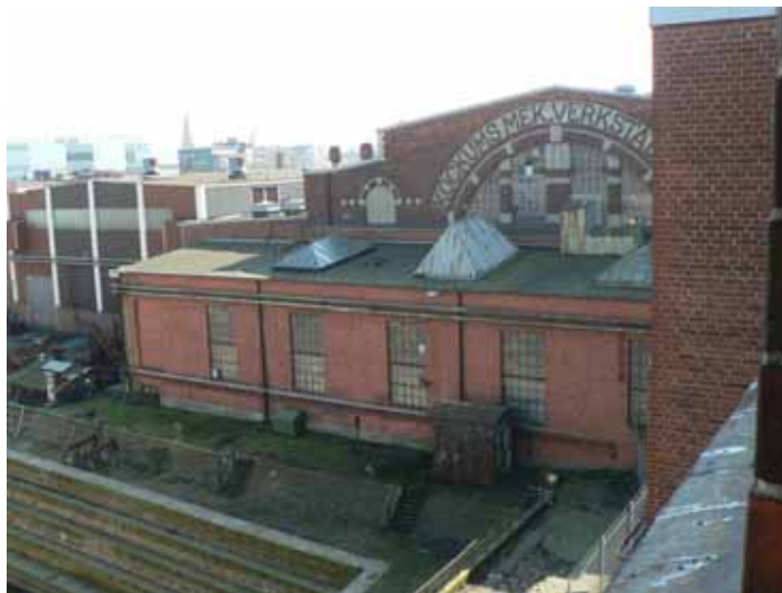
Tillbyggnad 7B sedd från norr.
