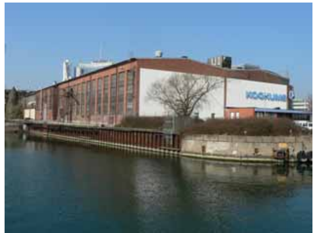
Maskinhallen sedd från öster.
