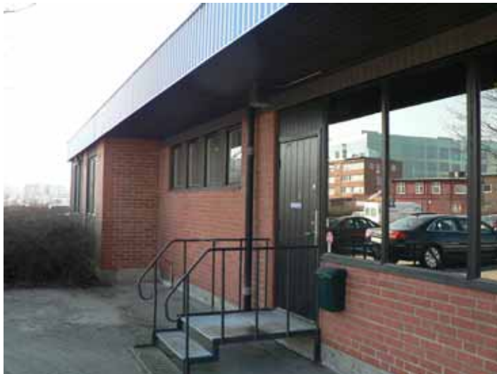
Östra vaktens östra fasad.
