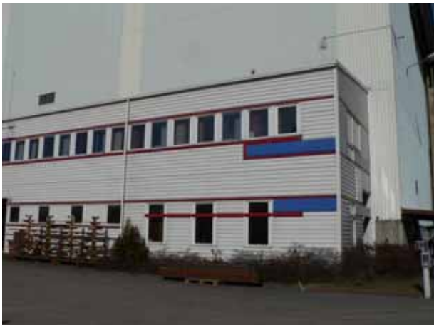
Kontorsbyggnaden vid den södra fasaden.
