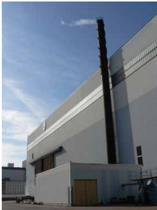
Hetvattenscentral sedd från norr.
