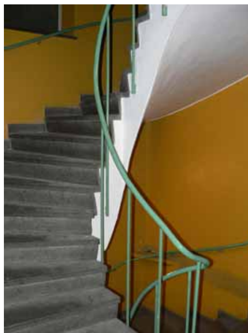
Interiör trappa i maskinhallens västra del.
