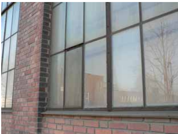
Detalj av maskinhallens norra fasad.
