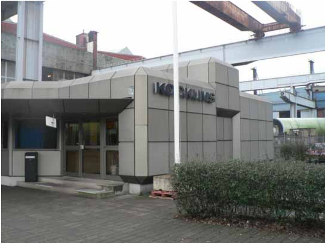
Vaktkuren sedd från nordöst.
