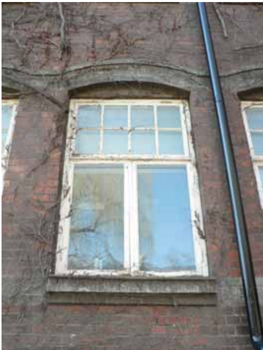
Originalfönster bevarat på gårdssidan.
