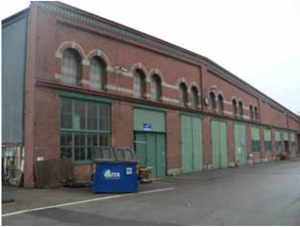
Vagnsverkstadens södra fasad.
