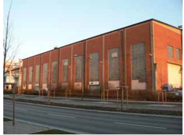
Verkstadshallen sedd från nordväst.
