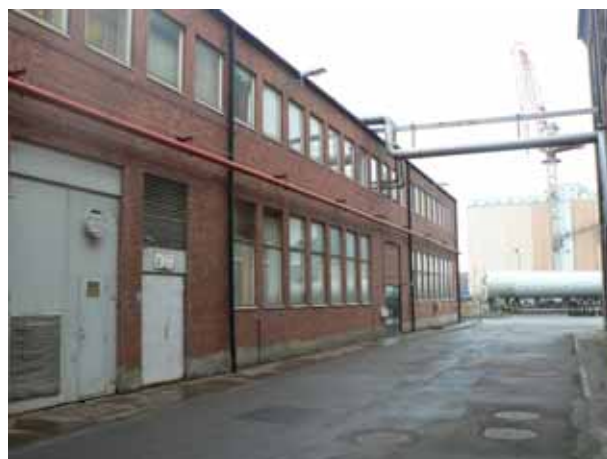
Rör- och elektrikerverkstadens västra fasad.
