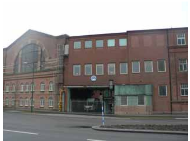
Administrationsbyggnadens tillbyggnad från 1940-talet, som länkar samman den med monteringshallen.
