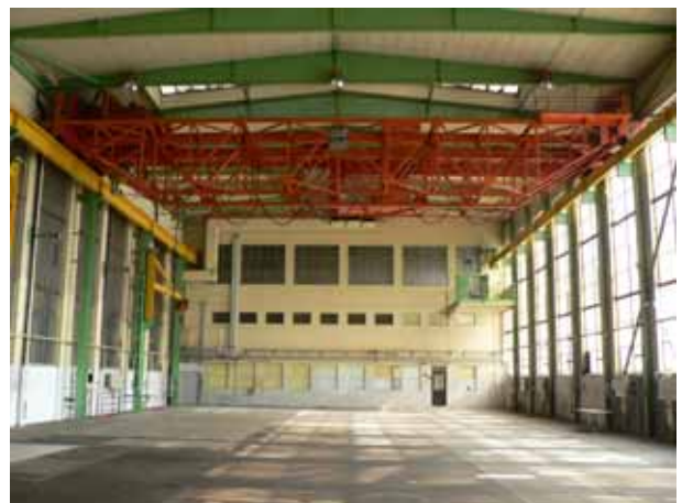
Maskinhallen, interiör sedd från väster.
