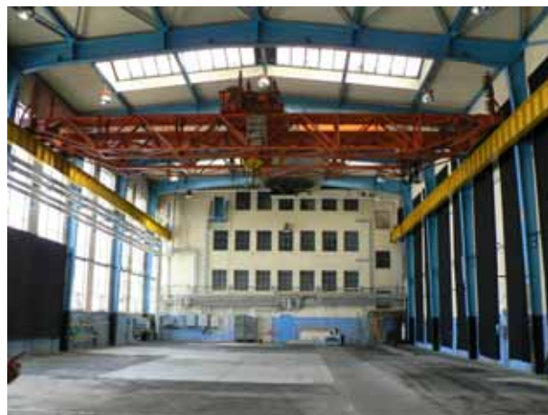
Maskinhallens interiör sedd från väster.
